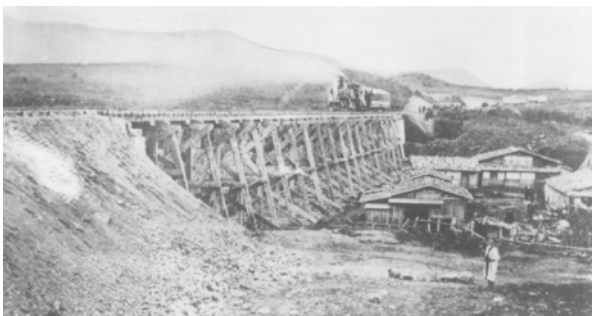
明治13年、幌内鉄道の試運転の風景。 弁慶号が入船陸橋を走っている （小樽市総合博物館所蔵）
