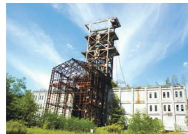
ドイツの技術を導入し1960年に建設されたが、わずか12年で閉山。一つの立坑シャフト中に、原炭輸送スキップと、人員炭車用ケージが一つずつ入る特異な形式。捲上深度650m、掘削深度735m、立坑櫓高さ51m。
