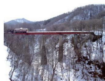
1944年に石炭増産の要請を受けて建設された芦別川支流の炭山川上に架かる三井炭山専用鉄道の橋梁。1945年12月竣工。橋長94m、高さ30m。鉄橋上にはディーゼル機関車と石炭専用貨車が展示されている。国登録有形文化財。
