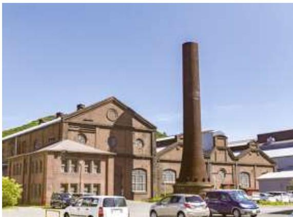
旧火力発電所（日本製鋼所）は、室蘭市で1909（明治 42）年に建設された火力発電施設です。煉瓦造で延床面積は3,241 m<sup>2</sup>。発電機3機とボイラー20基が格納され、1928（昭和 3）年に電力会社から初めて電力の供給を受けて自家発電との併用を開始しました。その後この発電所は予備扱となり、1961（昭和 36）年に廃止されました。
